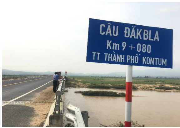
Hình 2.5. Cầu Đăk Bla 1 Km9+080 tại phía thượng lưu sông (Cầu đường tránh)
