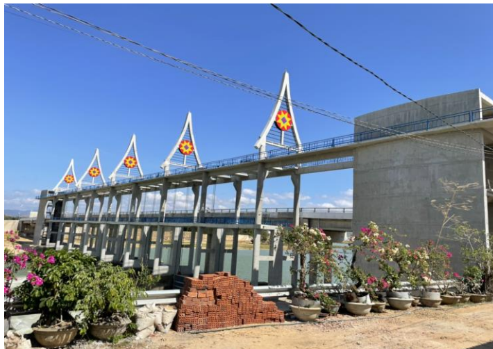
Hình 2.4. Công trình đập dâng số 02 gần Ngục Kon Tum đang vận hành
